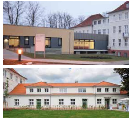
↑ Der OP-Trakt ist ein Anbau aus dem Jahr 2009.
