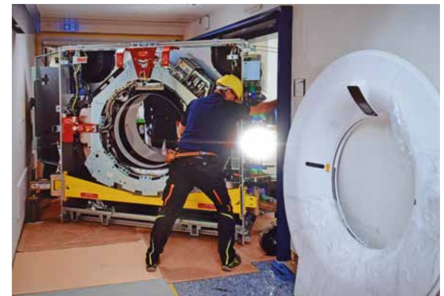
→ Allein die Größe der Geräte stellte die Installateure vor eine Herausforderung.
